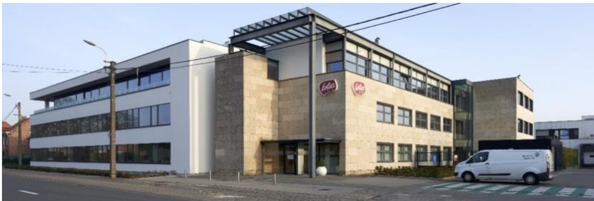
Kantoorgebouw Gentstraat 52 (zuidzijde)
